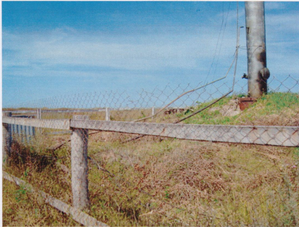
Рис.3 Ограждение первого пояса ЗСО. Справа водонапорная башня.
